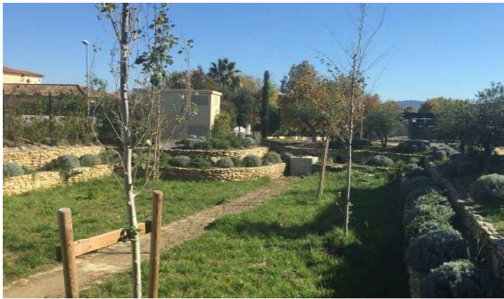
Exemple d'ouvrage de rétention paysager – Secteur la Combe Verte – Saussan (34)
